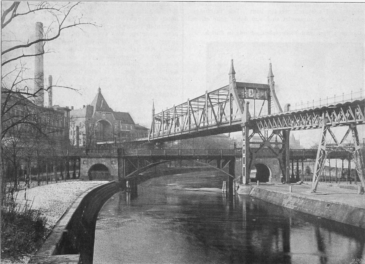
Abb. 15. Ueberbrückung des Landwehrkanals und der Anhalterbahn.
