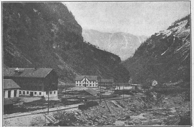
Abb. 55. Südseite. — Unterer Teil des Installationsplatzes.
