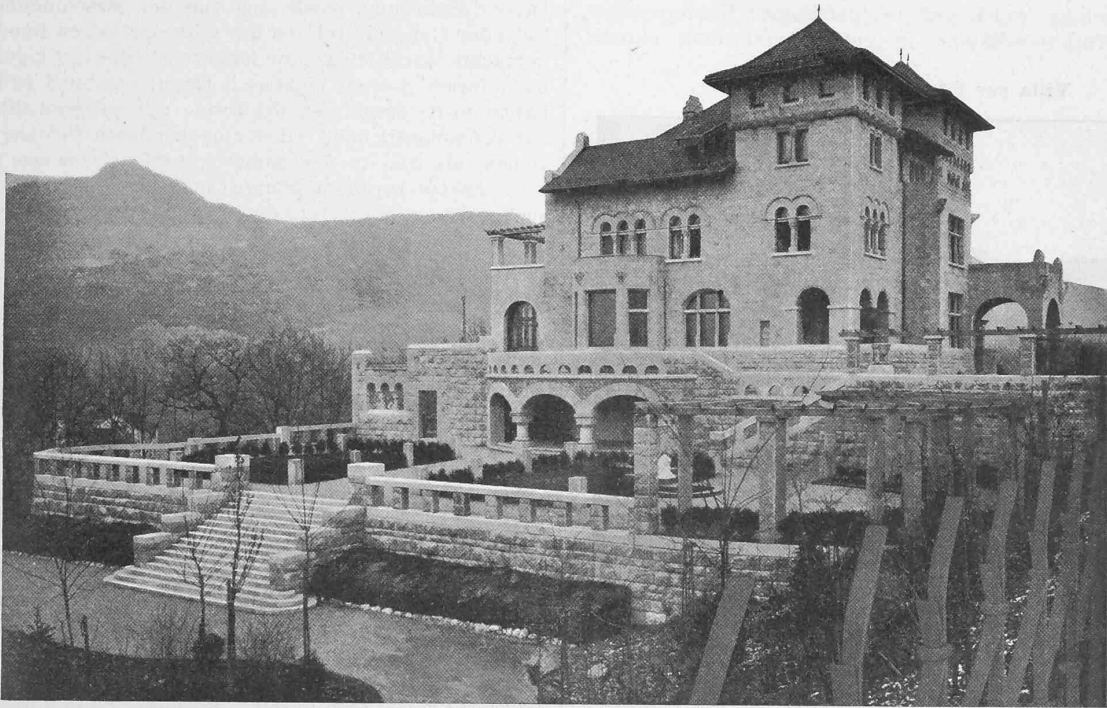
Abb. 4. Ansicht von Westen.
