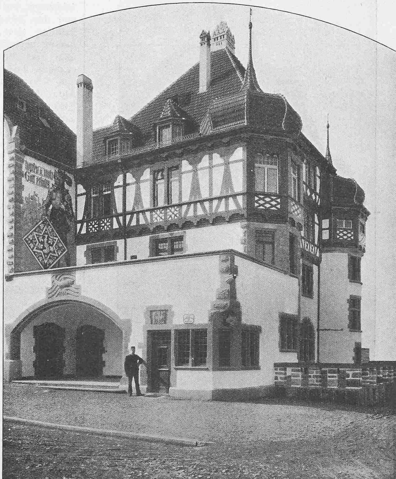
Abb. 1. Ansicht von Nordosten.
