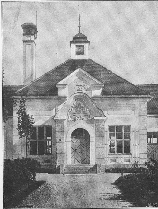
Abb. 9. Mittelpartie des Nebengebäudes.
