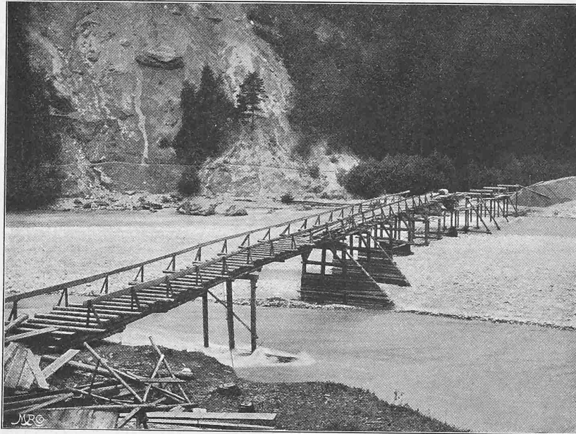
Abb. 3. Rollbahngerüst bei «Isla bella» (nach dem Hochwasser vom 15./16. Juni 1901).
