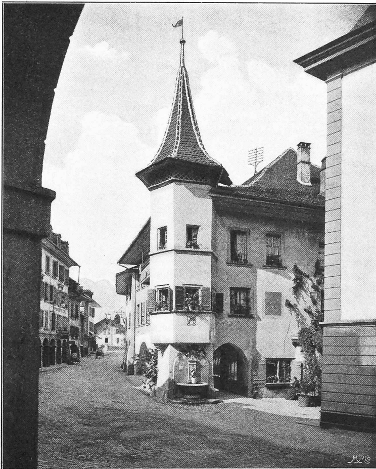
Erkerbau «zum Rosengarten» in Thun.
