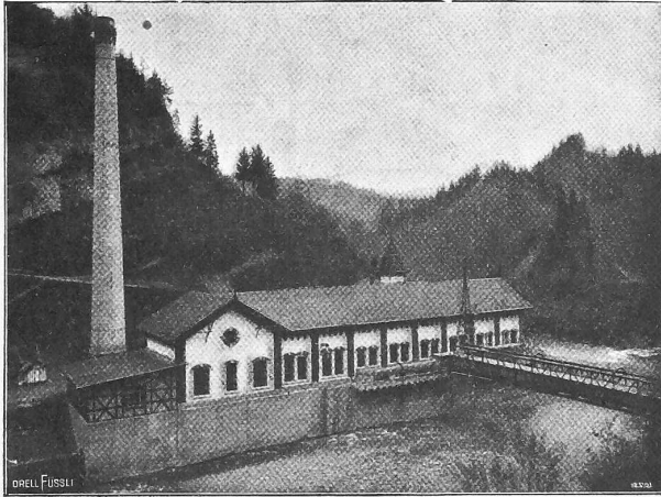
Abb. 32. Das Maschinenhaus, Ansicht von Westen.
