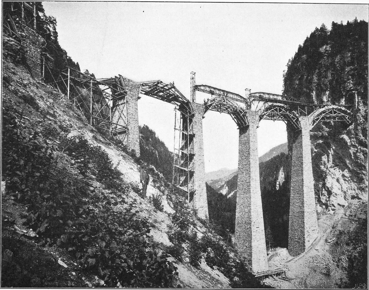
Abb. 15. Der Landwasserviadukt im Bau. Ansicht von Westen.
