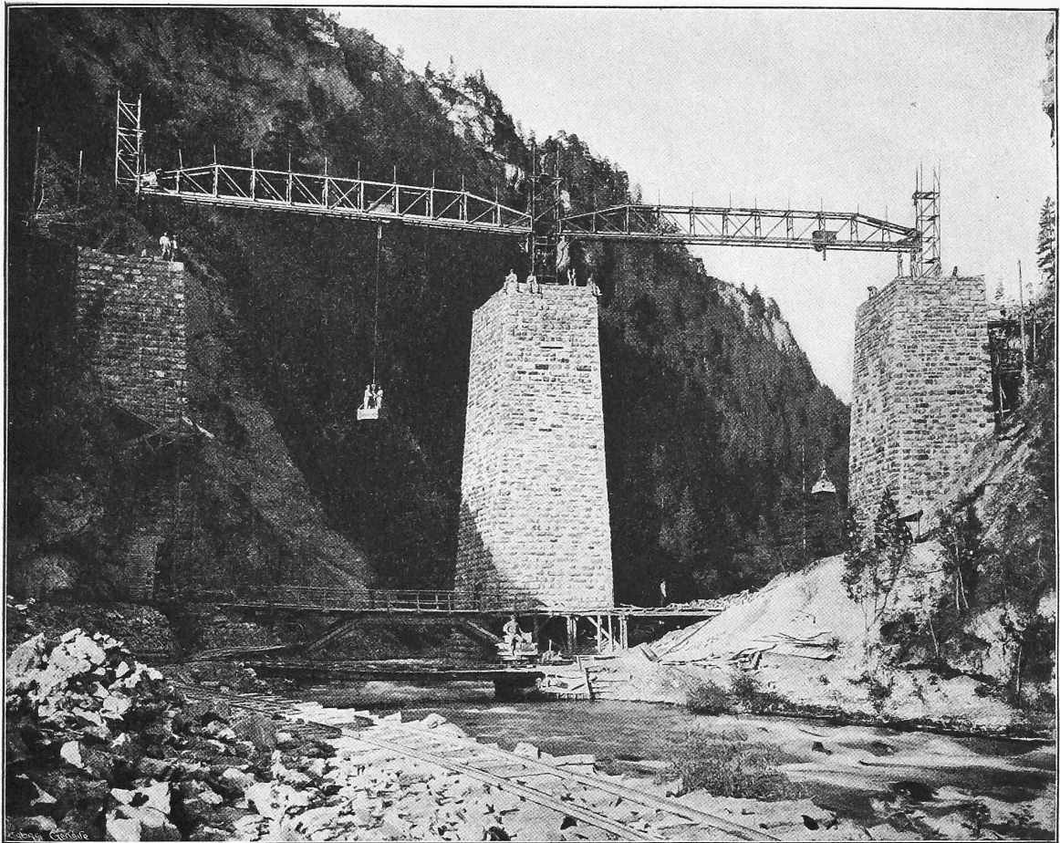
Abb. 14. Der Landwasserviadukt. — Auführung der grossen Mittelpfeiler.
