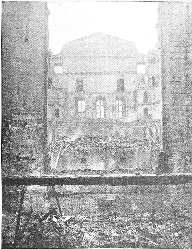
Abb. 4. Blick von der Bühne in den Zuschauerraum. Im Vordergrund der zerstörte eiserne Vorhang.
