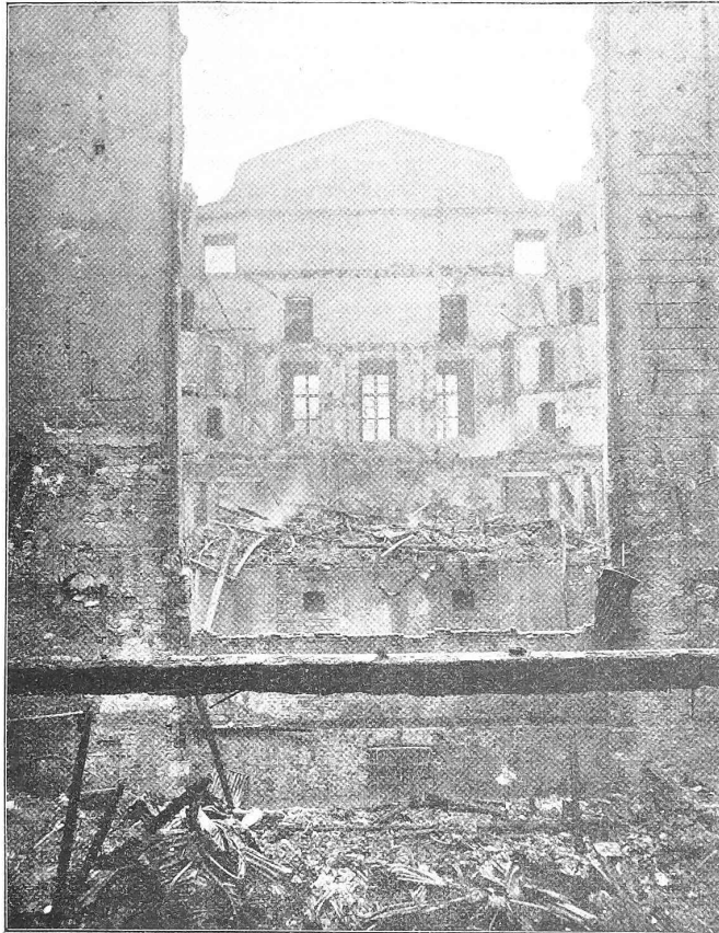
Abb. 4. Blick von der Bühne in den Zuschauerraum. Im Vordergrund der zerstörte eiserne Vorhang.
