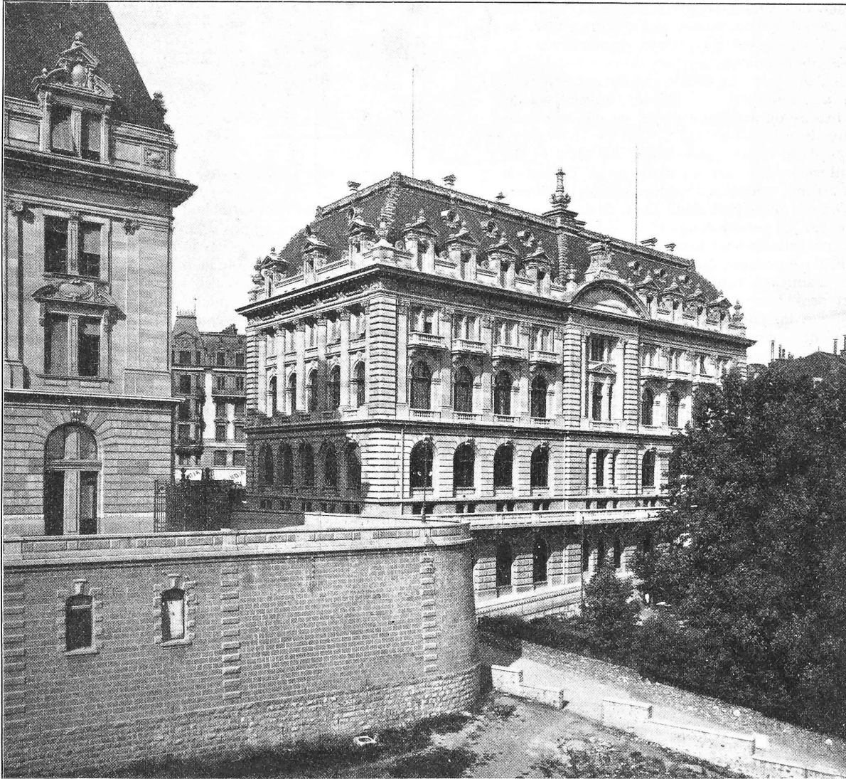
Fig. 1. Banque cantonale vaudoise. — Architecte: Francis Isoz. — Façade sud.
