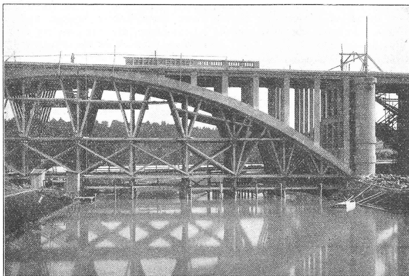
Abb. 12. Ansicht der linksufrigen Flussöffnung vor der Ausrüstung.
