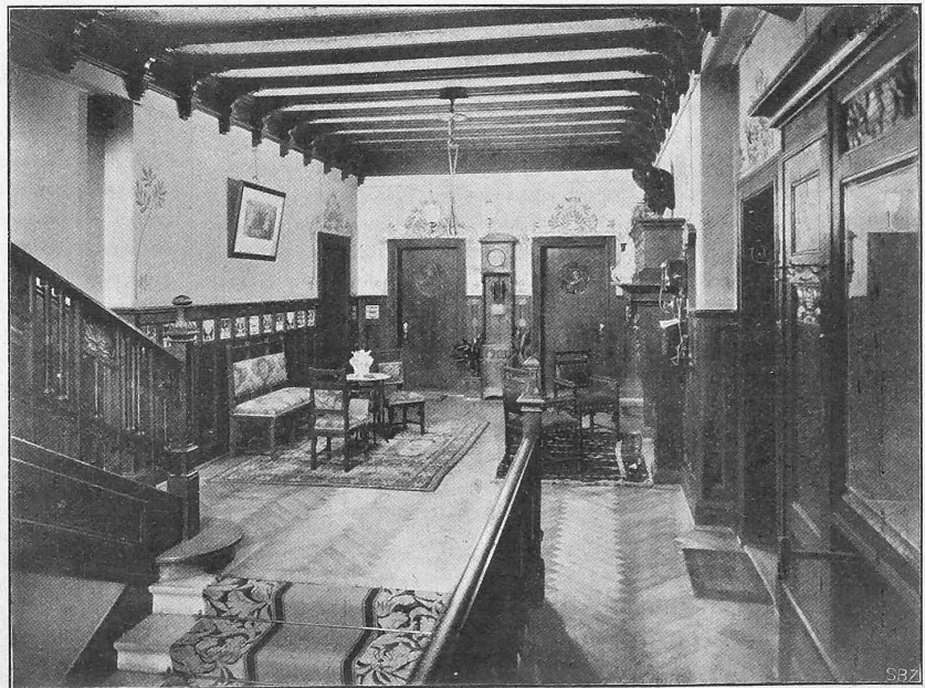
Abb. 20. Blick in die Halle der Villa E. Huber-Stockar in Zürich V.
