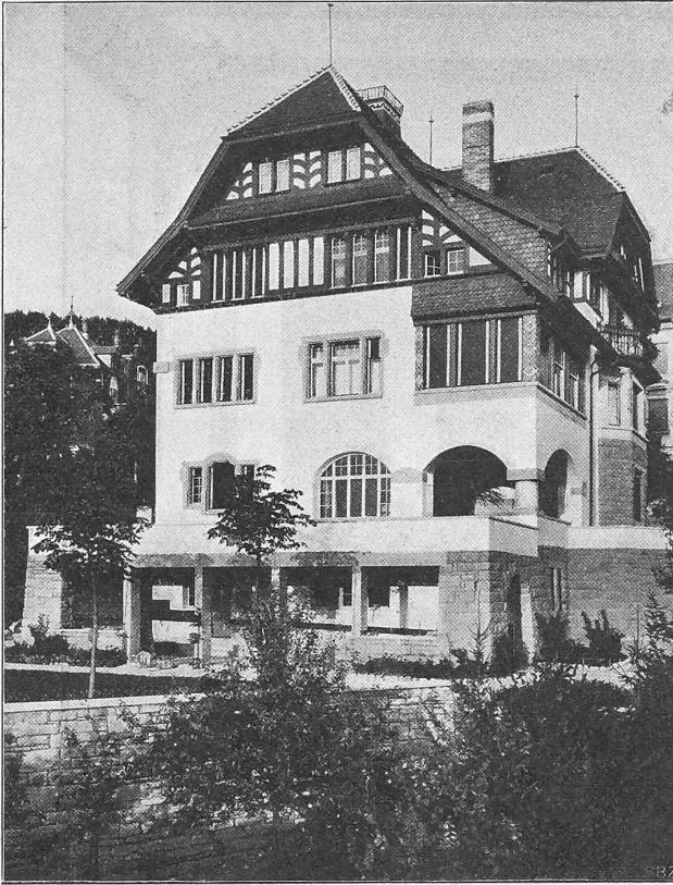
Abb. 14. Die Villa «Hadlaub» an der Rigistrasse in Zürich IV. Erbaut von den Architekten Pflegelhard & Haefeli in Zürich.
