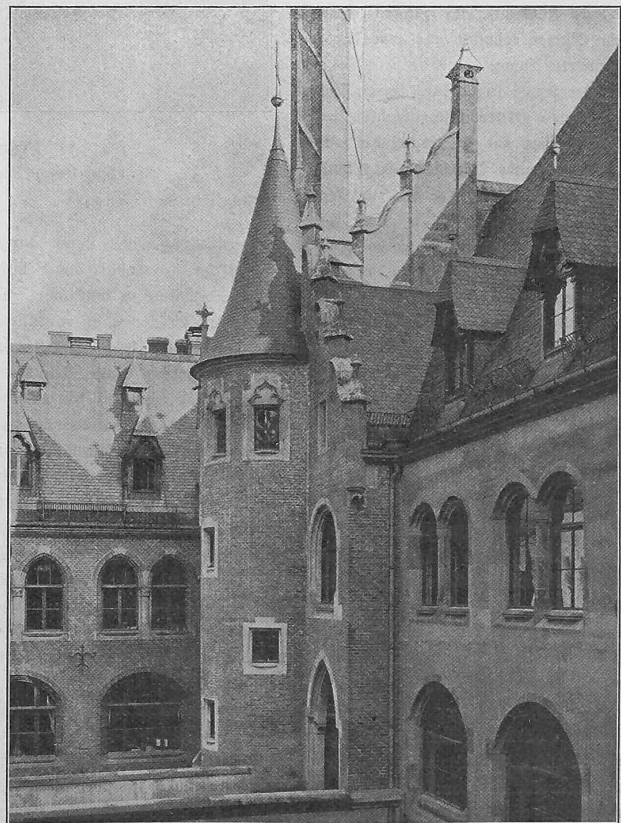
Abb. 12. Blick auf das Treppentürmchen des Kassenhofs.
