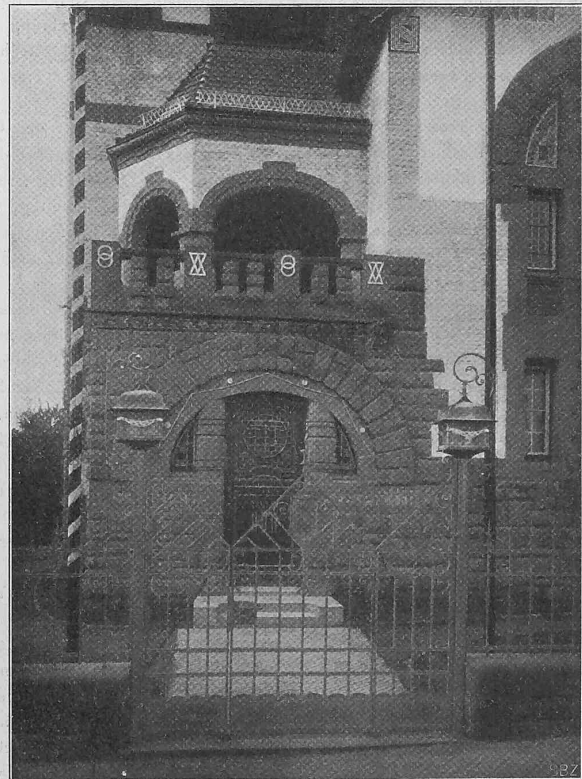
Abb. 3. Ansicht des Haupteingangs
