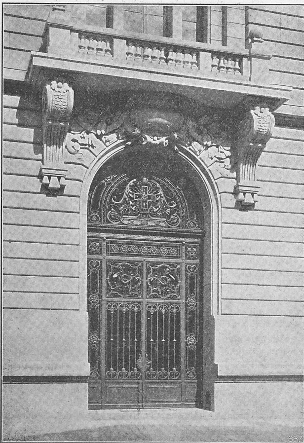
Abb. 8. Ansicht des Haupteingangs.
