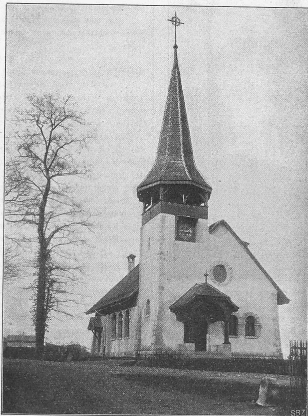
Fig. 1. Vue du côté de l'entrée principale.
