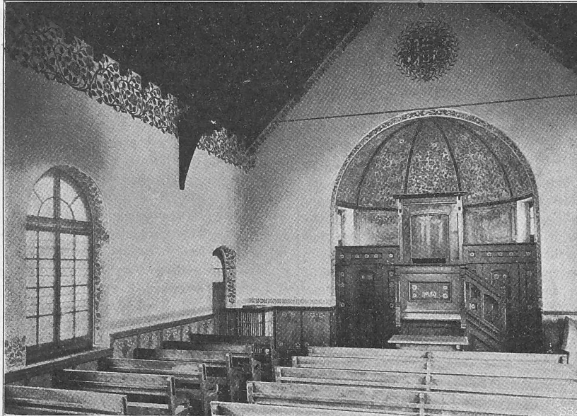
Fig. 4. Vue de l'intérieur.
