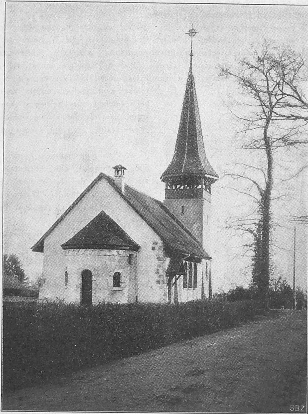
Fig. 2. Vue du chœur et de l'entrée latérale.
