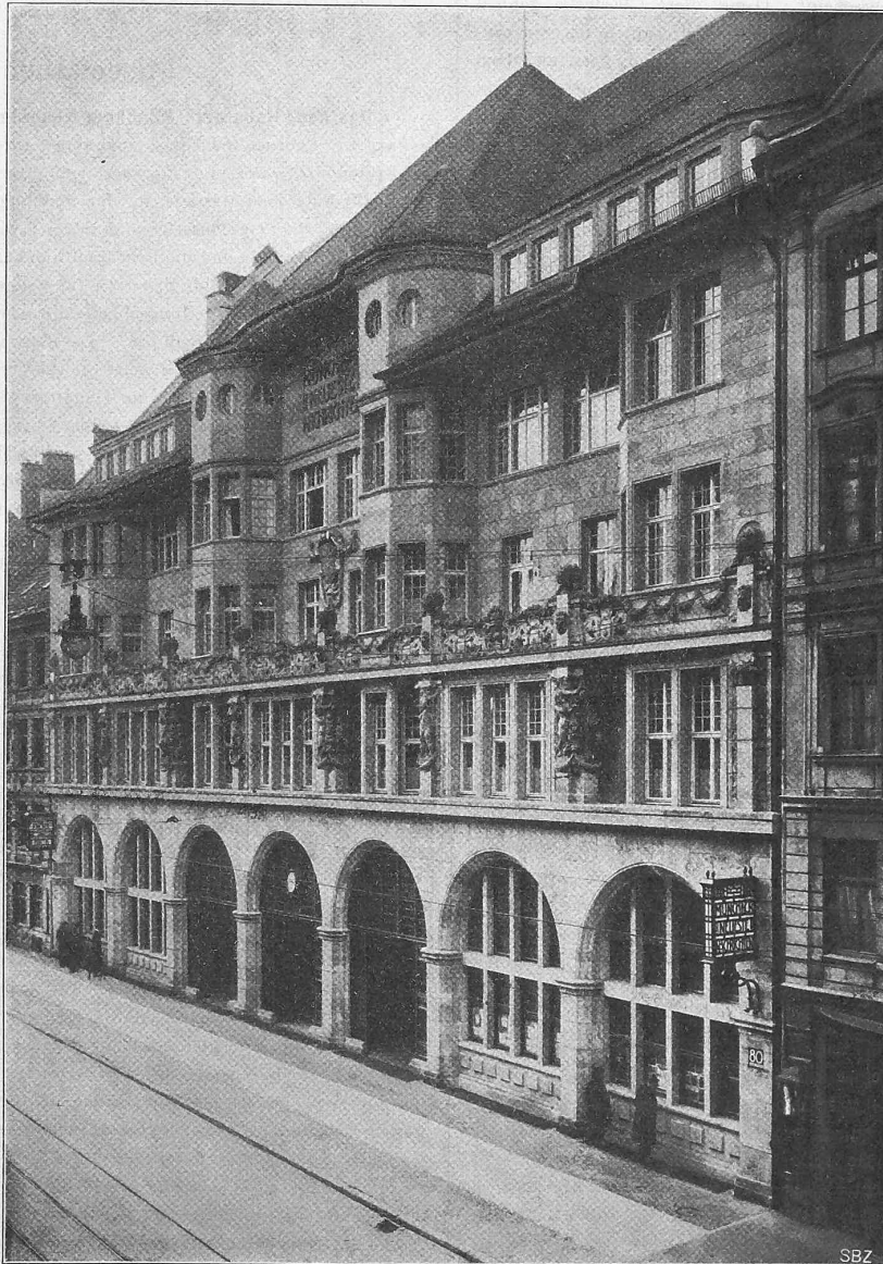
Ansicht der Hauptfassade an der Sendlingerstrasse.
