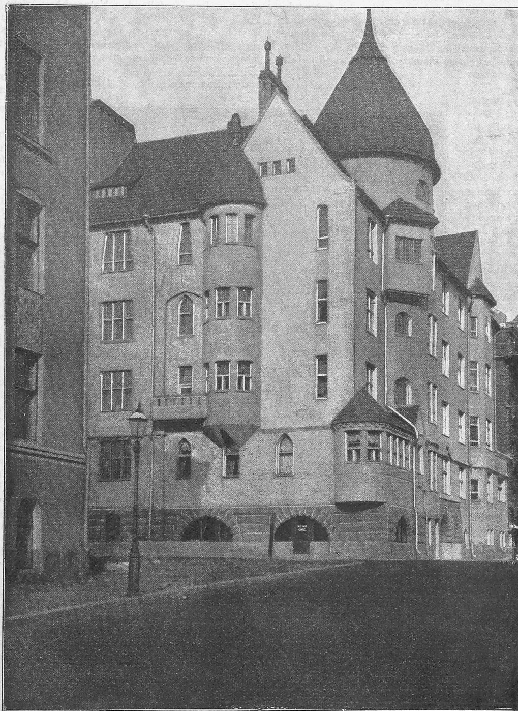
Abb. 5. Ansicht eines Wohn- und Geschäftshauses.
