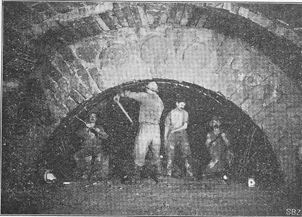
Abb. 49. Minen zum Sprengen der gemauerten Lehrbögen. 15. Jan. 1904.
