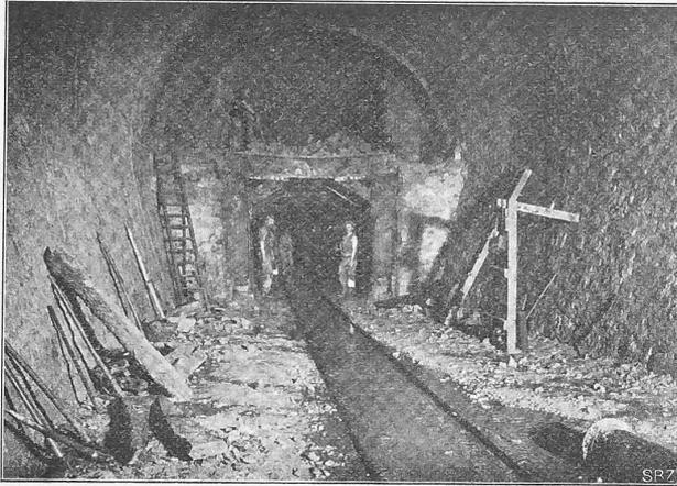
Abb. 51. Abbruch des innern Kerns nach Fertigstellung des Mauerwerks bei Km. 4,450/4,492. — 20. Januar 1904.
