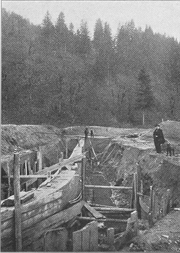
Abb. 9. Damm des Sammelweihers im Bau.
