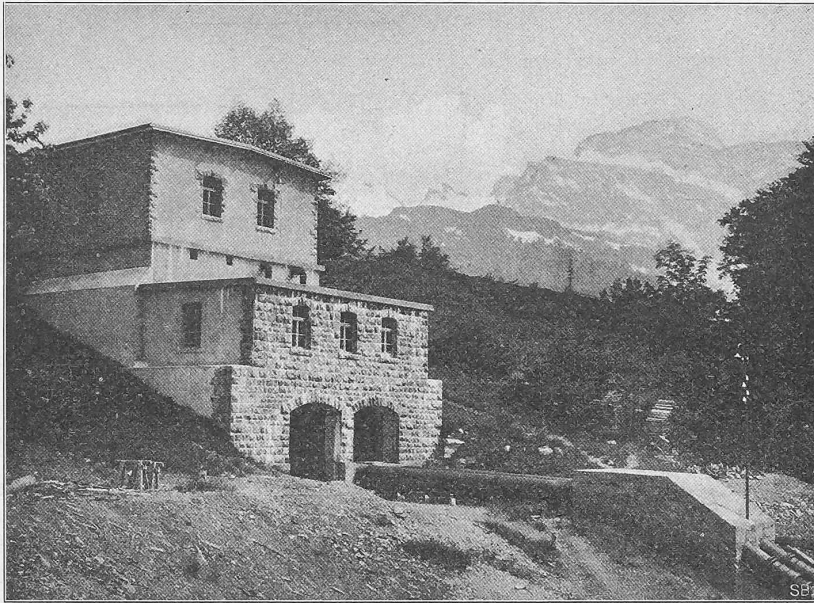
Abb. 17. Ansicht des Wasserschlosses im «Loch».
