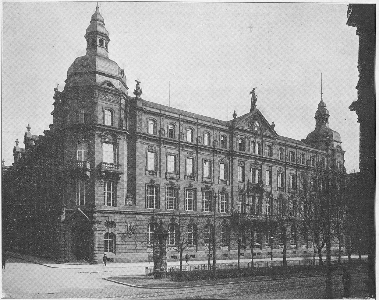
Abb. 1. Gesamtansicht der Hauptfassade.
