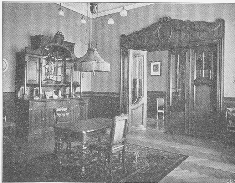
Abb. 13. Ansicht eines Zimmers der Dienstwohnungen.
