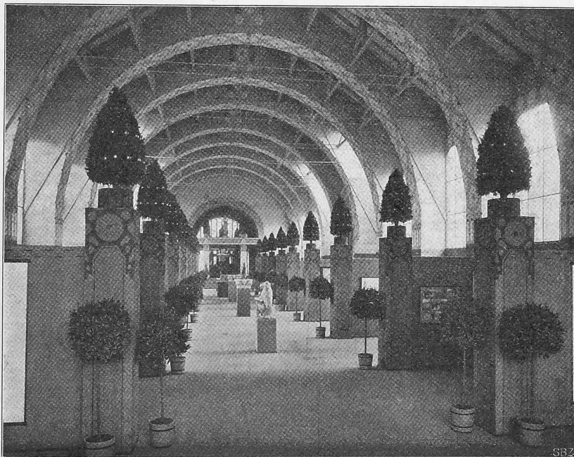
Abb. 14. Mittelhalle des Gebäudes des Bayerischen Staates.
