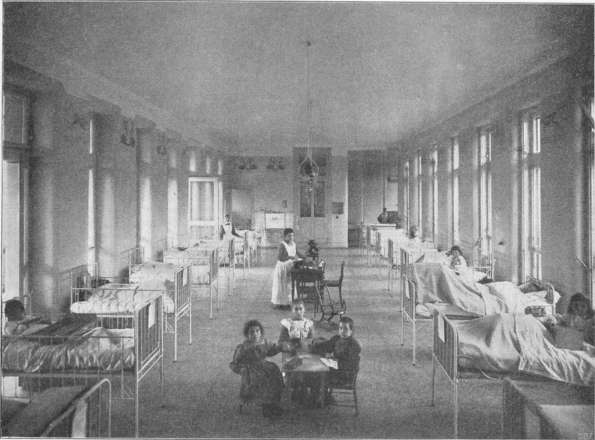
Abb. 17. Blick in den grossen Krankensaal des ersten Stockes.
