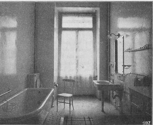
Abb. 17. Das Badezimmer eines Appartements.
