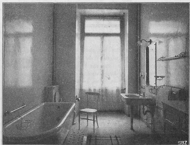
Abb. 17. Das Badezimmer eines Appartements.
