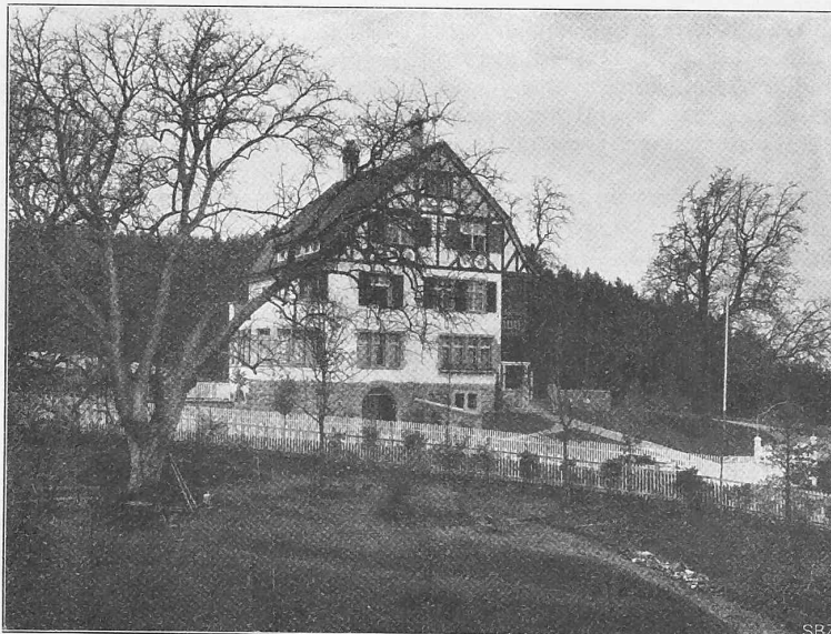
Abb. 4. Ansicht der Ost- und Südfassaden.
