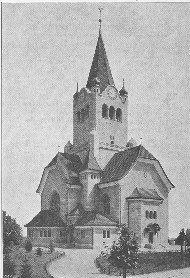
Abb. 5. Ansicht der Kirche von der Promenadenstrasse.
