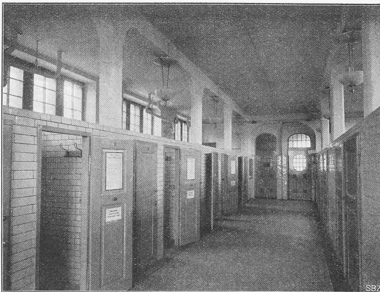
Abb. 10. Blick in den Mittelgang des Baderaums der Männerabteilung.
