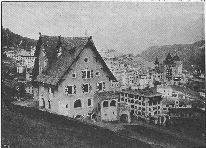
Abb. 8. Ansicht der Westfassade mit Blick nach St. Moritz-Dorf.
