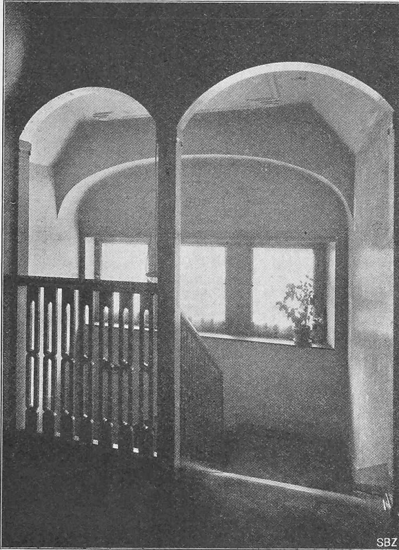
Abb. 9. Blick aus dem Dachgeschoss in das Treppenhaus der Villa Kubli-Schindler in Netstal.
