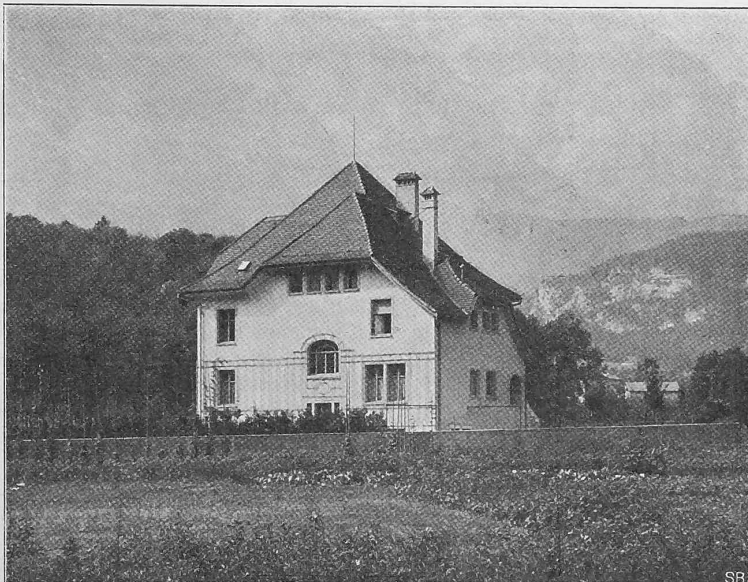
Abb. 6. Rückfassade der Villa Kubli-Schindler in Netstal.
