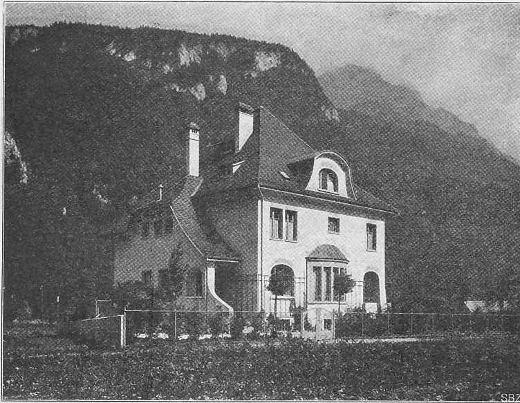
Abb. 1. Ansicht der Villa Kubli-Schindler in Netstal.
