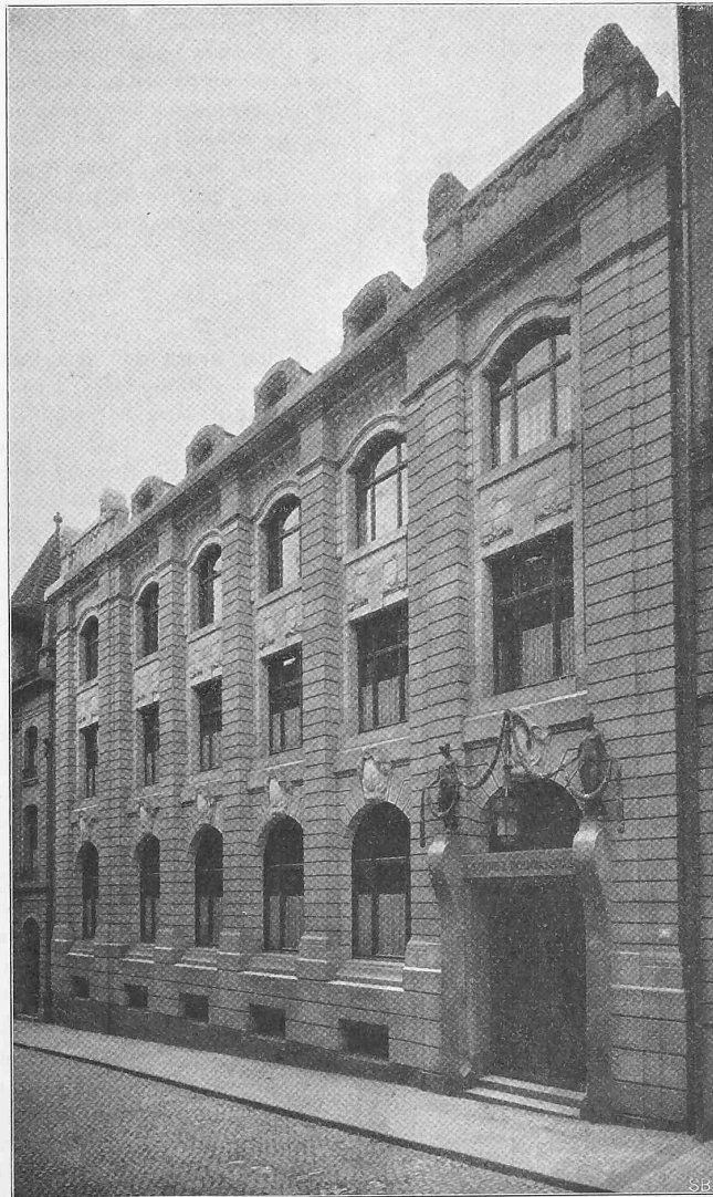
Abb. 10. Ansicht der Hauptfassade in der Freienstrasse.
