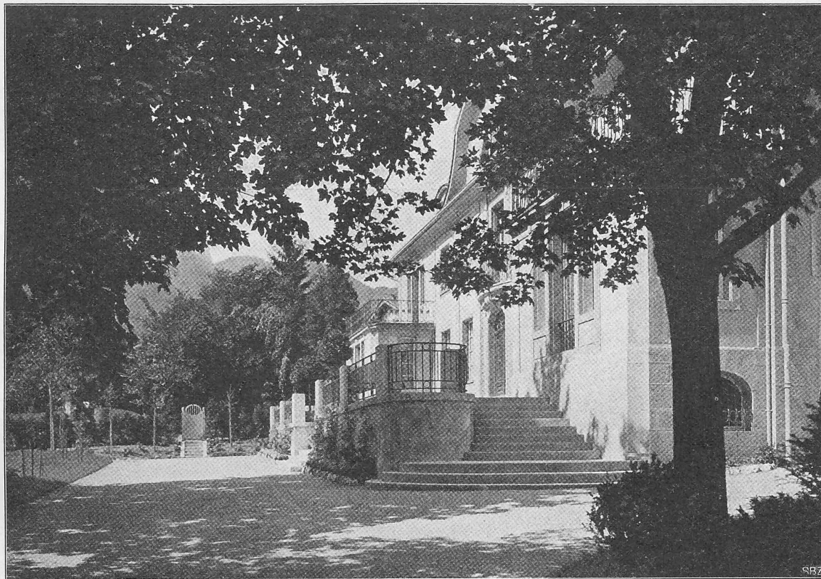
Abb. 16. Blick auf die Hauptfassade der Villa Schuler-Ganzoni in Glarus vom Gartenportal aus.
