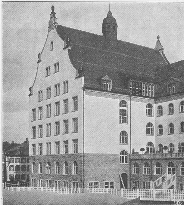
Abb. 8. Flügelbau der Rückfassade.
