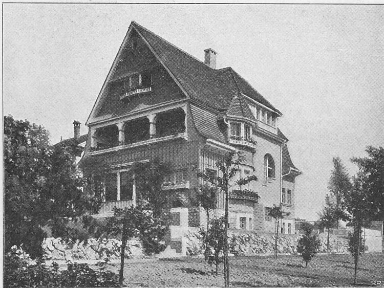
Abb. 1. Ansicht des Südostfassade des Hauses nach dem Garten.
