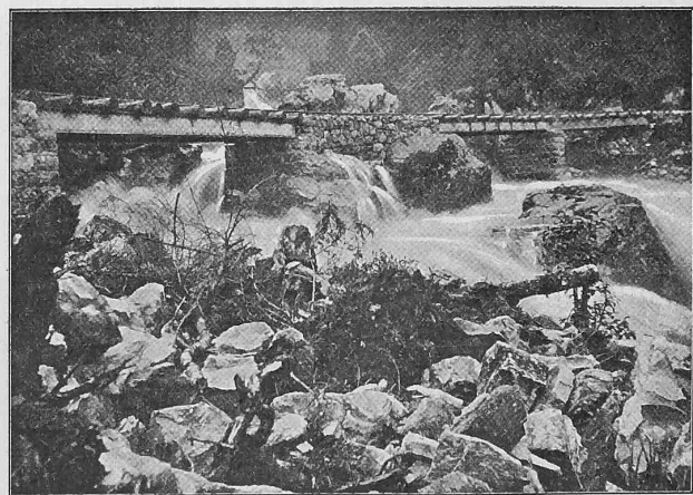
Abb. 14. Eiserne Balkenbrücke über die Kanderfälle.
