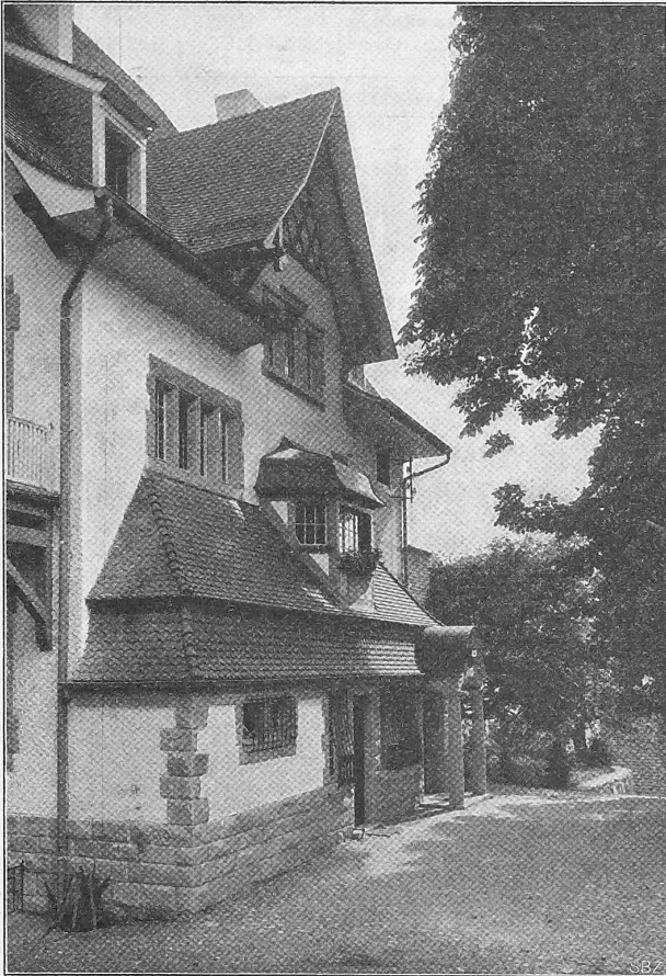
Abb. 4. Ansicht der Eingangsseite.
