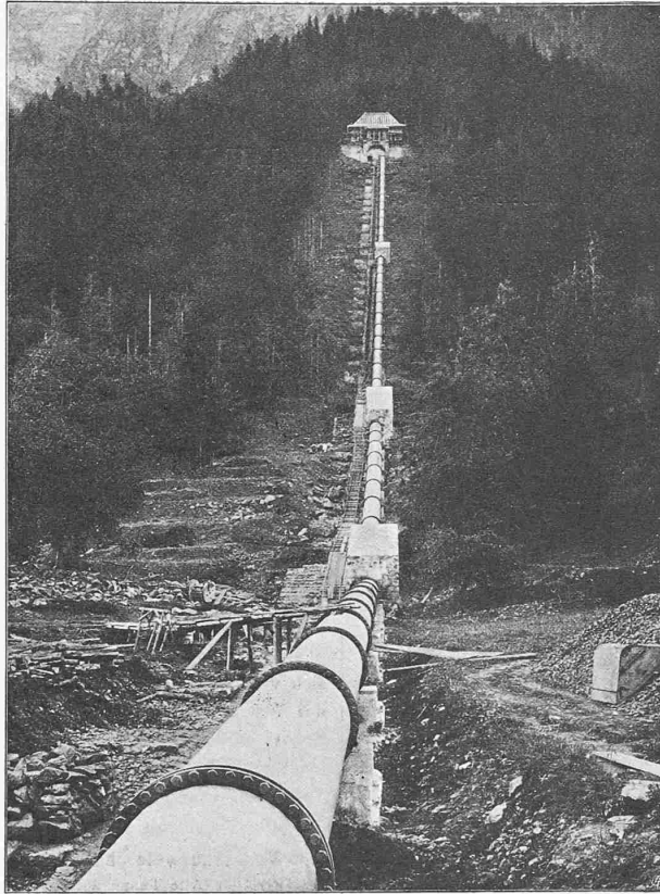
Abb. 17. Wasserschloss und Druckleitung I.
