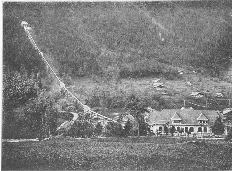
Abb. 15. Wasserschloss, Druckleitung und Maschinenhaus.
