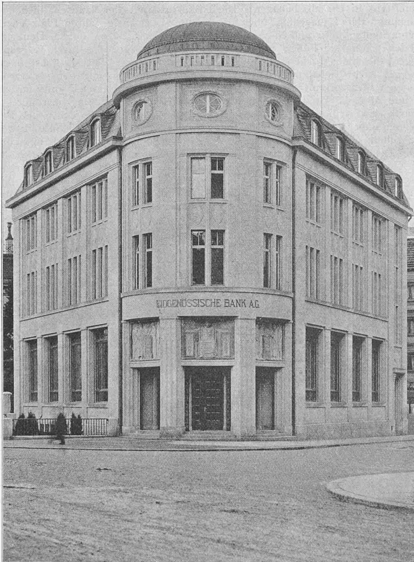
Abb. 5. Gesamtansicht von der Leonhardstrasse aus.
