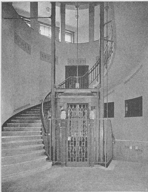
Abb. 8. Die Banktreppe im Erdgeschoss.
