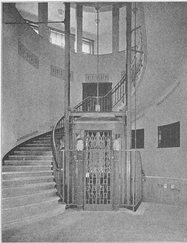
Abb. 8. Die Banktreppe im Erdgeschoss.
