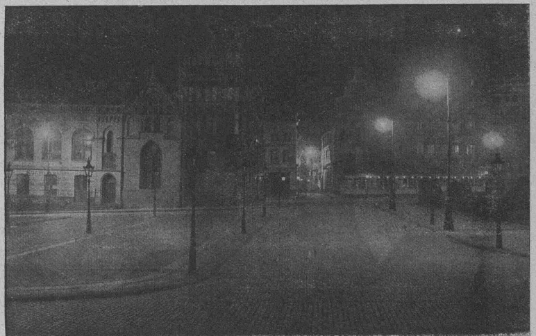
Fig. 3. Wechselstrom-Flammenbogenlampen mit TB-Kohlen in der Umgebung des Kölner Domes.
