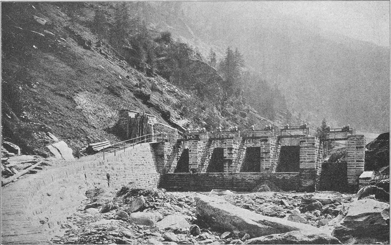
Abb. 6. Ansicht des Kanal-Stauwehrs in der Saaser Visp von der Unterwasserseite; rechts der Grundablass.
