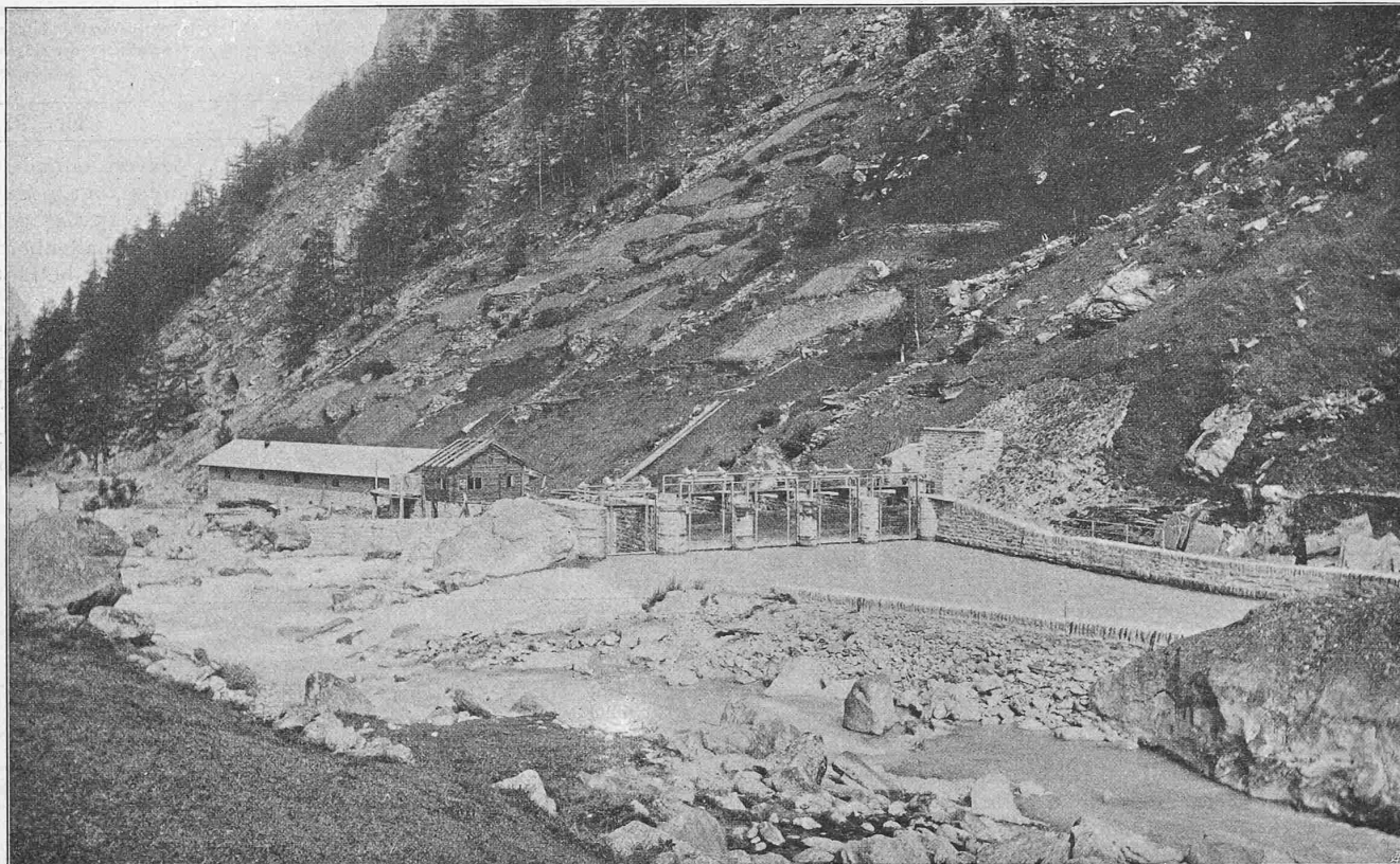
Abb. 4. Gesamtansicht der Fassung bei Saas-Balen mit Kläranlage und Wärterhaus (letzteres noch im Bau).
