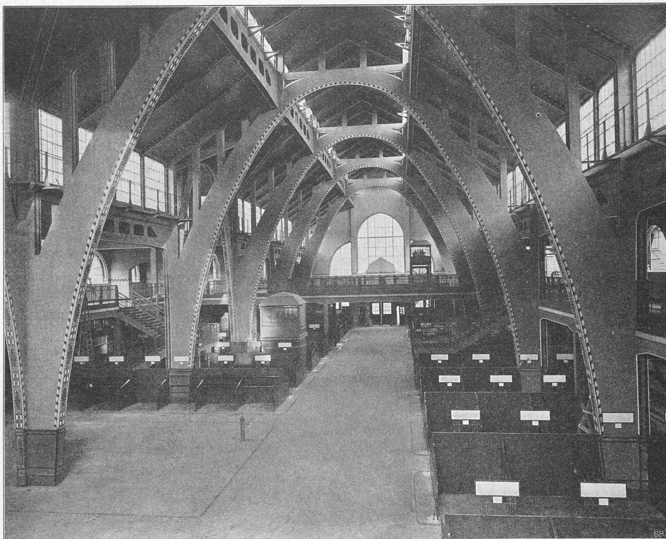
Abb. 1. Die Markthalle am Ritterplatz in Breslau; Blick gegen die Einfahrt an der Münzstrasse.
