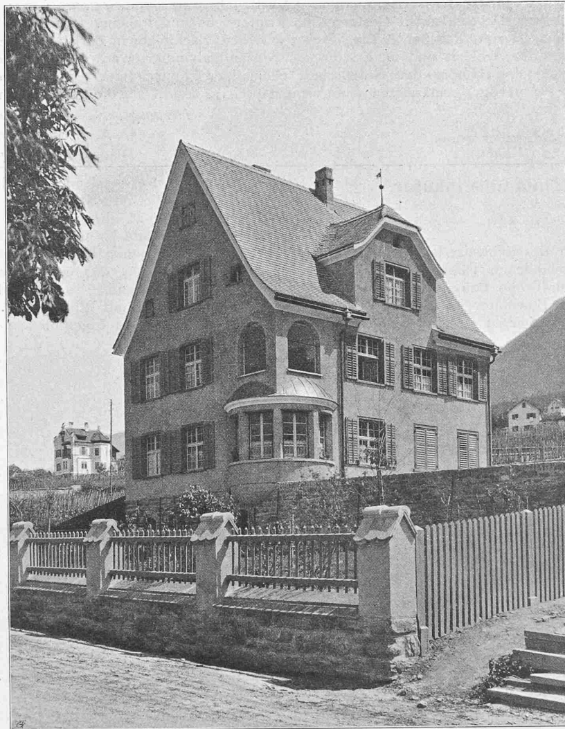
Abb. 4. Ansicht von Südwesten.
